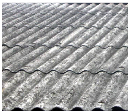
Rysunek 3.1 Wyroby azbestowo – cementowe: po lewej płyty faliste, po prawej płyty płaskie, typ „Karo”[źródło: materiały własne].
